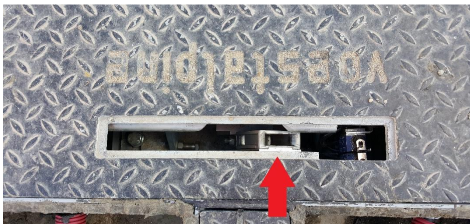
Figur 2: Indbygget drev - dæksel åbnet; pæl til omstilling ved rød pil
